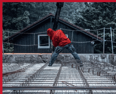
5. Betonage der Kelleraußenwände und -decke
