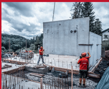
1. Versetzen der Kelleraußenwände
