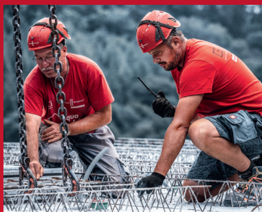
4. Verlegen der oberen Deckenbewehrung
