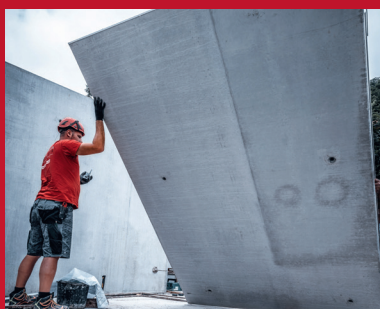
2. Versetzen der Kellerinnenwände
